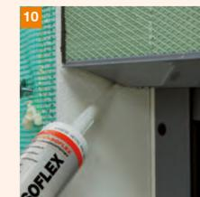
Die Fugen zwischen vorgesetzten Rollokästen und Laibungsplatte im oberen Bereich bzw. zwischen Bordstück der Fensterbank und Platte im unteren Bereich sorgfältig mit GIMA-Densoflex abspritzen und abziehen. **TIPP:** Mit einem Kunststoffplättchen funktioniert das Abziehen des Dichtstoffes sauber und einfach.
