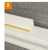
Aufkleben des abgelängten VDS-15-Laibungsanschlussprofils an den Fensterstock.
