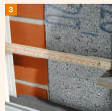
Maß der LPS-Platten für Sturz und Laibung ermitteln. Gegebenenfalls im Verhältnis zum Fenster ausmitteln. Ebenso wird das Gefälle des Bordstückes ausgemessen und auf die LPS-Platte übertragen. **HINWEIS:** Die Sturzplatte muss mit den seitlichen Laibungsplatten abschließen. Die Plattentiefe ermittelt sich aus dem Abstand der Innenseite des VDS-Laibungsanschlussprofils bis zur WDV-Vorderkante der späteren Armierungsschicht. Toleranzen in der Laibungsplattentiefe von max. - 5 mm sind zulässig.
