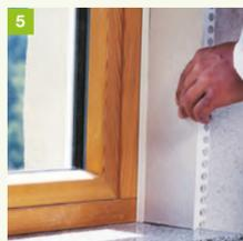
Einschub der primusLPS-Laibungsplatten in die zuvor am Fenster angebrachten Einfassprofile. Durch ein leicht schräges Einschleiben der Platten ist der Einschubwiderstand geringer und die Platte lässt sich leichter montieren.
