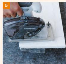
Der Zuschnitt der primusLPS-Laibungsplatten erfolgt mit der Akku-Handkreissäge Art.-Nr. 3502-100 oder anderen geeigneten Werkzeugen. **HINWEIS:** Falls die Plattentiefe nicht wie in Schritt 3 beschrieben ausgehend von der Innenseite des ADL-Profilkopfes sondern direkt am Fensterstock ermittelt wurde, ist die Plattentiefe um 5 mm zu reduzieren, so dass die Stärke des ADL-Profiles mit berücksichtigt wird!
