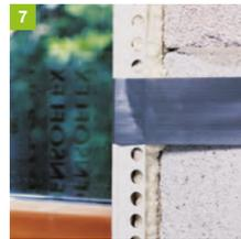
Die primusLPS-Laibungsplatte mit dem L-Winkel nochmals ausrichten und mit einem Steinklebeband am Mauerwerk fixieren bis der Schaum abgeunden hat.
