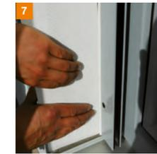
Die Laibungsplatten in das Anschlussprofil VDR 15 einschleiben. **WICHTIG:** Der Eckbereich zwischen Bordstück und Profil ist mit Densoflex vor dem Einschleiben der Platte schlagregendicht zu versiegeln. **TIPP:** Durch ein leicht schräges Einschleiben der Platten ist der Einschubwiderstand geringer und die Platte lässt sich deutlich leichter montieren.
