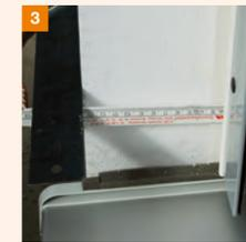
Maß der LPS-Platte für Höhe und Laibungstiefe ermitteln. Ebenso wird das Gefälle des Bordstückes ausgemessen. **HINWEIS:** Die Plattentiefe ermittelt sich aus dem Abstand der Innenseite des Profils bis zur WDV-Vorderkante der späteren Armierungsschicht. Bei vorgesetzten Rollokästen ist die Plattenlänge oben bündig mit der Oberkante des Rollokastens vorzusehen. Toleranzen in der Laibungsplattentiefe von max. - 5 mm sind zulässig.
