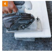
Der Zuschnitt der Laibungsplatten erfolgt mit der Akku-Handkreissäge Art.-Nr. 3502-100 oder anderen geeigneten Werkzeugen. **TIPP:** Der GIMA Gerüstisch Art.-Nr. 3655-000 bietet eine sichere Plattform für alle Zuricht- und Montagearbeiten.
