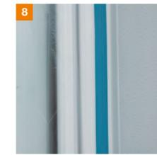
Zum Schutz der Fensterfläche kann an die Abdecklasche eine PVC-Folie angeklebt werden. **TIPP:** Verwenden Sie transparente oder seidenmatte Folie, um Licht ins Innere des Gebäudes dringen zu lassen.
