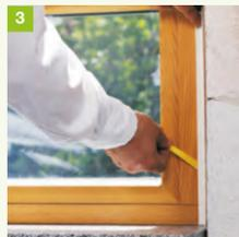
Nach Überprüfung des Abstandes zwischen Fensterbeschlag und Laibung wird das Einfassprofil 3736 auf den Fensterstock aufgeklebt. Zuerst im Sturz-, dann im Laibungsbereich.
