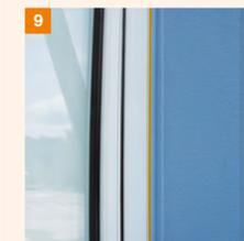
Fassade und Laibungen streichen, hierbei kann bis an die Abdecklasche herangearbeitet werden. Sollen auch die Laibungen mit einem Oberputz versehen werden, ist der sichtbare Schenkel des VDS-Profiles im Vorfeld mit einem Klebebandstreifen zu schützen. Nach den Verputzarbeiten das Klebeband entfernen und den sichtbaren Profilschenkel im entsprechenden Farbton überstreichen.
