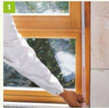
Maß der primusLPS-Platten für Sturz und Laibung ermitteln. Gegebenenfalls im Verhältnis zum Fenster ausmitteln. Die Sturzplatte wird über die gesamte Fensterbreite eingemessen. Die Plattentiefe ermittelt sich aus dem Abstand von Fensterstock bis zur Mauerwerksvorderkante zuzüglich der späteren Innenputzdicke. Die ermittelten Maße werden im Anschluss auf die Laibungsplatten übertragen.
