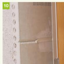
Ist eine Laibung länger als eine einzelne Platte, so werden die primusLPS-GK Platten an den Stirnseiten angefast und stumpf gestoßen eingebaut. Nach Aushärtung des Montageschaums wird die Fuge sauber mit Fugenfüller verspachtelt.
