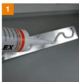
GIMA U-Profil Aluminium ablängen und zum Verkleben GIMA Densoflex auftragen.
