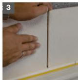
Platten stoßen. Die Stoßfugen von Platten und Profilen müssen mindestens 10 cm versetzt sein. Nach Aushärtung können die Platten mit einer Oberputzbeschichtung versehen oder gestrichen werden.
