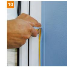
Nach dem Streichen der Fassaden- und Laibungsflächen entfernen der PVC-Folie in den Fensterflächen und Abziehen der Abdecklasche vom VDS-Profil. Das Ergebnis ist eine optisch perfekte und schlagregendichte Laibungsbauweise!
