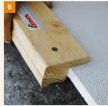
Mit dem ADL-Nuthobel Art.Nr. 937-260 wird die Nut zum Einschleiben des ADL-Profiles 3726 in die primusLPS-Platte geschnitten. **TIPP:** Durch Erhöhung der Schnitttiefe ist der Hobel auch zur Ausbildung von Nutungen zur Aufnahme des LPS-Verbindungsprofils Art.Nr. 3720-120 bei Plattenstößen einsetzbar.
