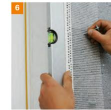
Nach der Montage der jeweiligen Laibungsplatte wird diese mit dem L-Winkel bzw. der Wasserwaage ausgerichtet und mit Stiften in der schon aufgetragenen Fassadendämmung fixiert. **TIPP:** Überschüssigen Schaum nach dessen Aushärtung mit einem Spachtel oder Ähnlichem entfernen und Fixierungsstifte wieder entfernen.
