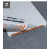
GIMA LPS-Verbindungsprofil Art.Nr. 3720-120 als Fixierhilfe einlegen und mit LPS-Verbindungs Kleber Art.Nr. 1245-310 verkleben. Auf die Stirnseite des LPS-Verbindungsprofils ebenfalls Verbindungs Kleber auftragen.
