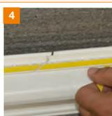
Aufkleben des weiteren ADL-Profiles 3726 mit 3 mm Dehnungsabstand zum zuvor aufgeklebten ADL-Profil.
