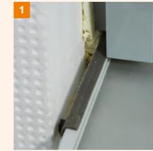
Aufkleben des Kompribandes auf die Fensterbank oder deren Bordstücke. Später wird hier die LPS-Platte aufgesetzt. **WICHTIG:** Das Kompriband muss ca. 3 mm von der Vorderkante der LPS-Platte zurückgesetzt sein, damit der Anschluss später sauber verfugt werden kann. **HINWEIS:** Bei WDV-Systemen muss das Band auch um die Bordstücke und unter der Fensterbank verlaufen.
