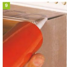
Die Fugen im Eckbereich und zwischen Fensterbank und primusLPS-Laibungsplatten sorgfältig mit GIMA-Densoflex absiegeln und abziehen.
