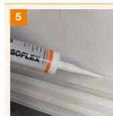
Versiegeln des sichtbaren Profilstückes mit GIMA Densoflex.
