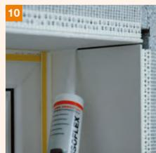
Die Fugen im Eckbereich und zwischen Fensterbank und Laibungsplatten sorgfältig mit GIMA-Densoflex absiegeln und abziehen.
