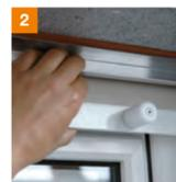
GIMA U-Profil Aluminium auf die Unterseite des Rollokastens kleben.
