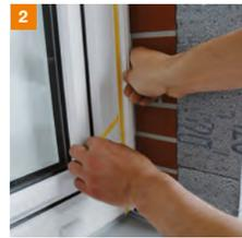
Ablängen der ADL-Profil 3726 mit Hilfe der GIMA Multischere Art.-Nr. 7120-215 und anschließendes Ankleben an den Fensterstock im Sturz- und Laibungsbereich. **TIPP:** Abdecklasche beim Sturzprofil ausklinken. **HINWEIS:** Es ist bei der Verklebung grundsätzlich der Untergrund bzw. Fensterrahmen mit einem geeigneten Reniger zu säubern. Bei Fensterbänken mit seitlichen Bordstücken sollte der vordere Schenkel des Profils bündig zur Bordstückvorderkante sein.
