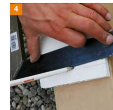
Die ermittelten Maße werden im Anschluss auf die Laibungsplatten übertragen. **HINWEIS:** Gewissenhaftes Messen und Anzeichnen erleichtern die spätere Montage der Platte erheblich.
