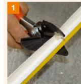
Ablängen des Laibungsanschlussprofils VDR 15 im 90°-Winkel mit der GIMA Multischere.
