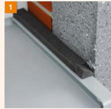
Aufkleben des Kompribandes auf die Fensterbank oder deren Bordstücke. Später wird hier die primusLPS-Platte aufgesetzt. **WICHTIG:** Das Kompriband muss ca. 3 mm von der Vorderkante der primusLPS-Platte zurückgesetzt sein, damit der Anschluss später sauber verfugt werden kann. **HINWEIS:** Bei WDV-Systemen muss das Band auch um die Bordstücke und unter der Fensterbank verlaufen.
