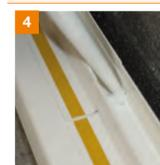
Versiegeln der Fuge zwischen den VDS-15-Laibungsanschlussprofilen mit Densoflex.
