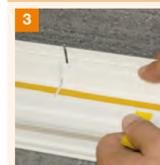
Aufkleben eines weiteren 90° abgelängten VDS-15-Laibungsanschlussprofils mit 3 mm Dehnungsabstand zum zuvor aufgeklebten Profil.
