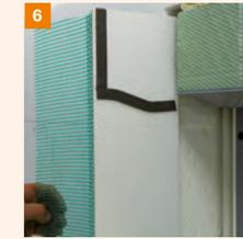
Bevor die LPS-Platte in ihre Einbaulage verbracht wird, sind bei vorgesetzten Rollokästen die seitlichen Umrisse des Kastens auf die Platte zu übertragen. Im Anschluss wird, wie auf dem Foto erkennbar, ein Kompribandstreifen an den angezeichneten Umriss auf die Platte aufgeklebt. **HINWEIS:** Mit dem Kompriband etwa 3 mm vom angezeichneten Umriss nach innen entfernt bleiben.
