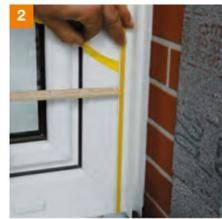
Ablängen des Laibungsanschlussprofils VDS 15 mit Hilfe der GIMA Multischere Art.-Nr. 7120-215 und anschließendes Ankleben an den Fensterstock im Sturz- und Laibungsbereich. **TIPP:** Auf saubere Klebeflächen achten! Abdecklasche beim Sturzprofil ausklinken. **HINWEIS:** Bei Fensterbänken mit seitlichen Bordstücken sollte der vordere Schenkel des Profils bündig zur Bordstückvorderkante sein.
