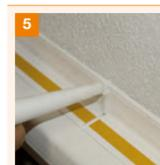
Versiegeln des sichtbaren Profilschenkels mit GIMA Densoflex.
