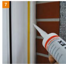
In die U-förmige Öffnung des ADL-Profilkopfes wird eine Dichtraupe mit Densoflex (Densoflex-Schnur) Art.Nr. 8310-5022 gezogen, um einen dauerhaft schlagregendichten Anschluss der Laibungsplatte an das ADL-Profil sicherzustellen. **TIPP:** Densoflex muss in die zur Laibung zeigenden hinteren Ecke des Profils 3726 aufgebracht werden.
