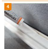
Versiegeln der Fuge zwischen den Laibungsanschlussprofilen VDR 15 mit Densoflex.
