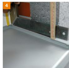
Neigungswinkel des Bordstückes bestimmen. Dies kann wie im Bild erfolgen oder mit Hilfe einer Schmiege auf die primusLPS-Platte übertragen werden.
