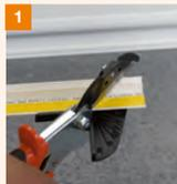
Ablängen des ADL-Profiles 3726 im 45°-Winkel mit der GIMA Multischere.
